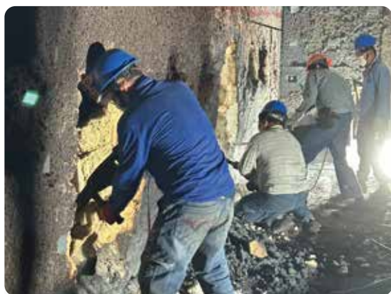
① 東和鋼鐵進行加熱爐體耐火材之更換
