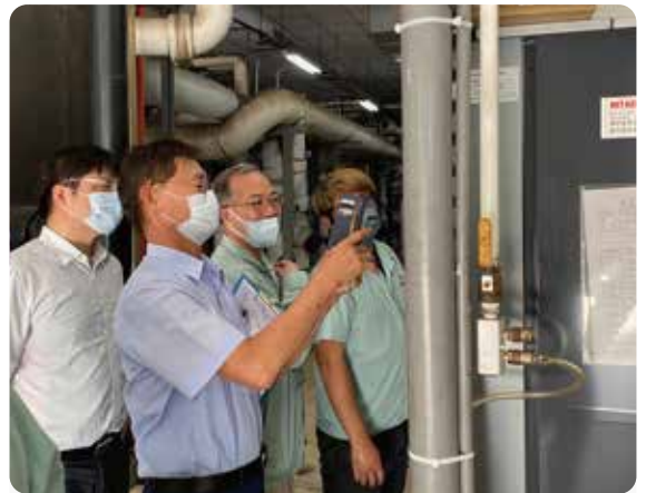
1 園管局輔導團前往瑞儀光電勘查現況，透過專業儀器設備找出能耗現況。
