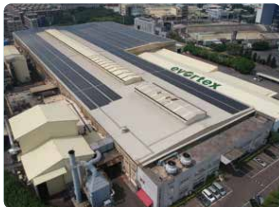
1 大統新創投入約8,000萬元於廠房屋頂設置太陽能發電，年發電量可達200萬度。
