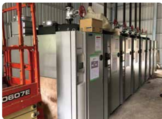
1 蒸汽鍋爐煤轉氣，年減碳量可達1.14萬公噸CO 2 。
