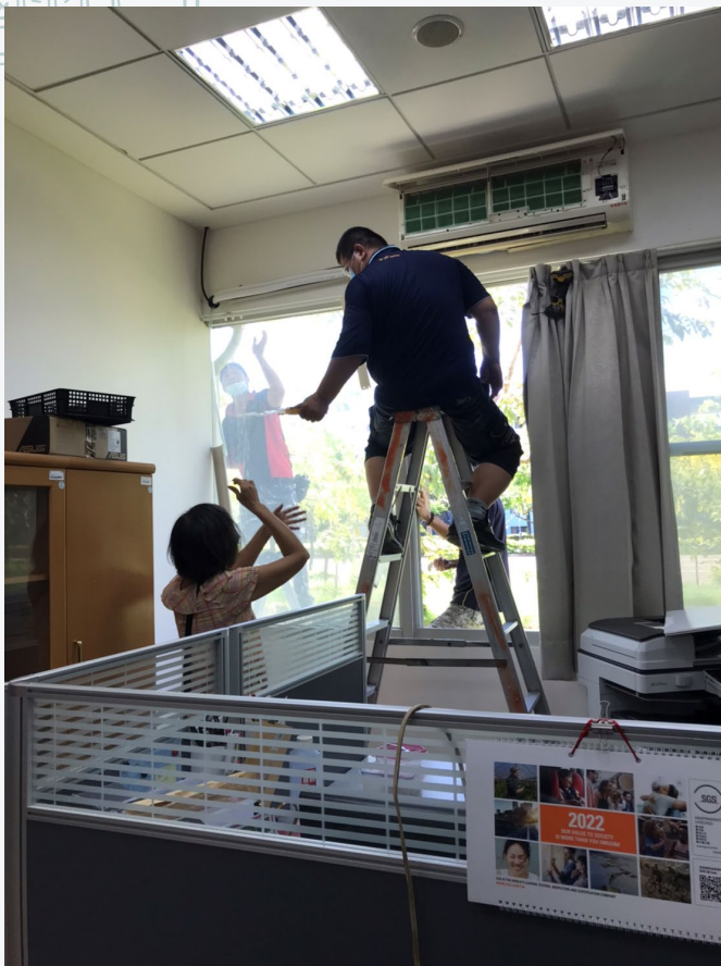
照片: 聯盟辦公室安裝冷氣
